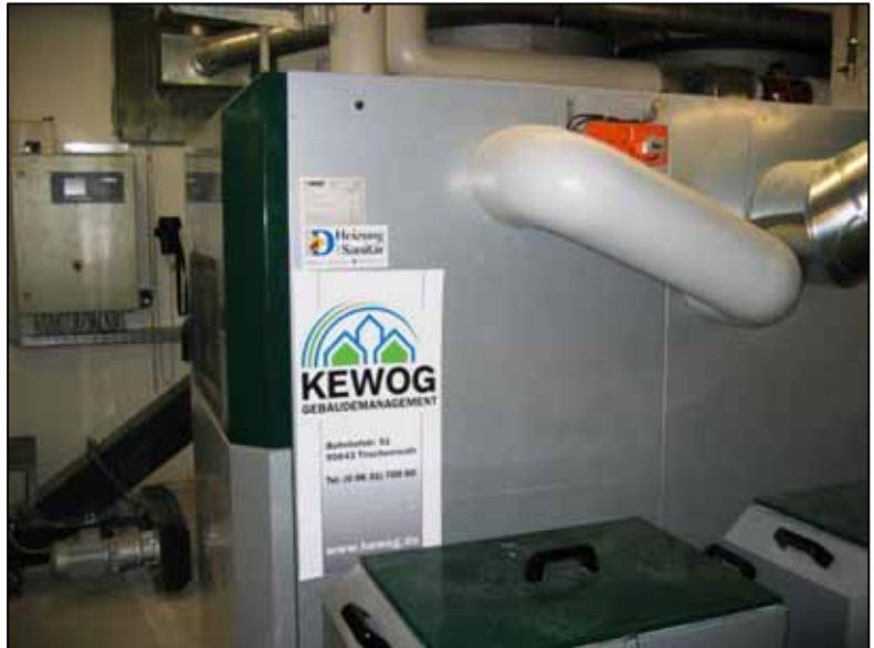
4 Blick auf den Pellets-Kessel
